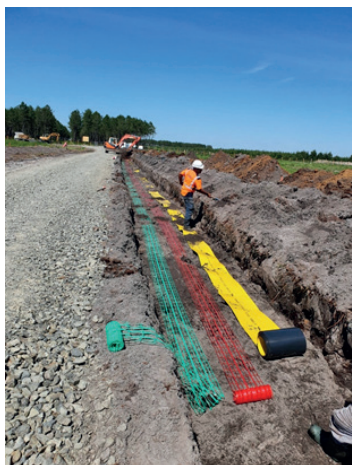
Installation du réseau de câbles interne au parc
