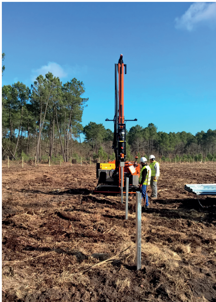
Battage des pieux
