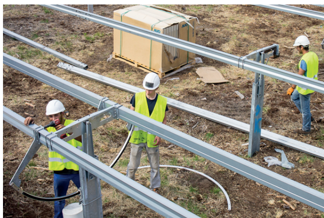
Montage des supports
