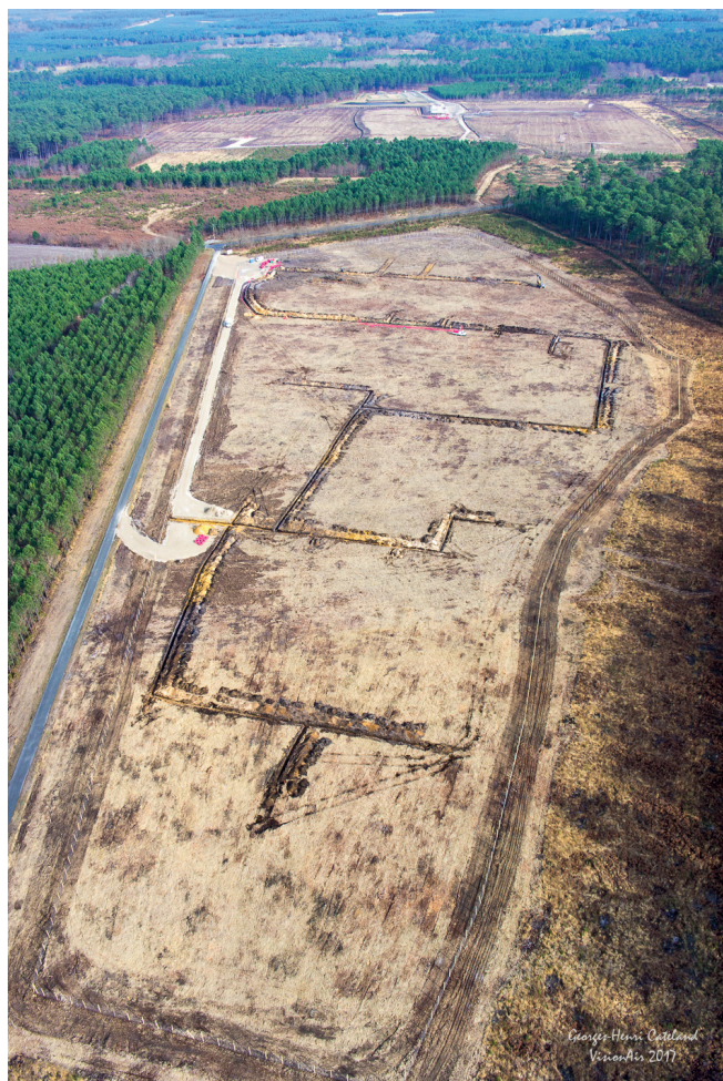
Travaux «lourds» : création des pistes, passages de câbles...
