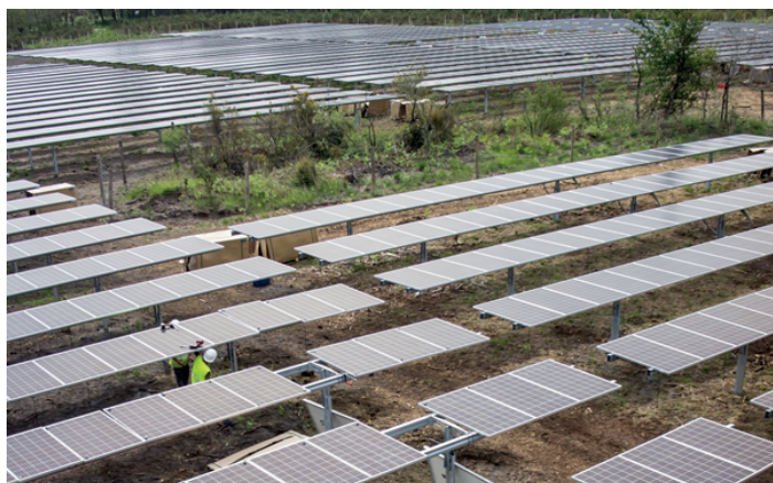
Montage des panneaux
